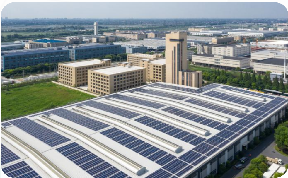
BAPV (在现有建筑上安装光伏组件)
